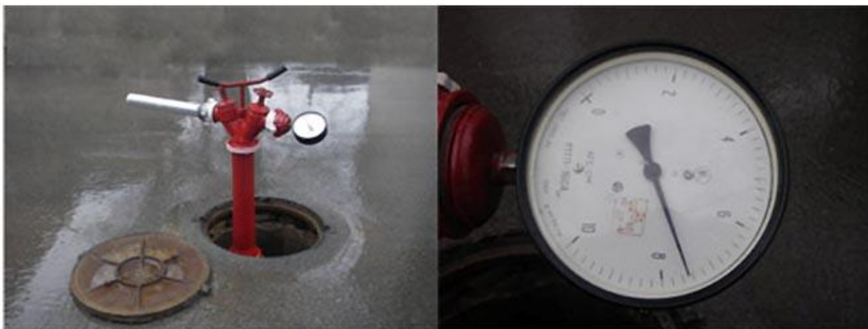
Рисунок 1. Устройство для испытания водопроводной сети на водоотдачу
