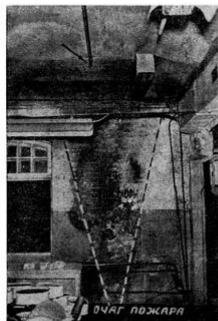
Рис. 2. Во время пожара на складе фабрики «Скороход» вскрылась спринклерная головка над очагом горения.
