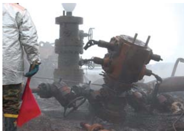
Рис. 3. Демонтаж трубной головки
