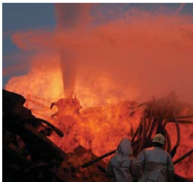
Рис. 2. Создание компактной струи газа на устье скважины
