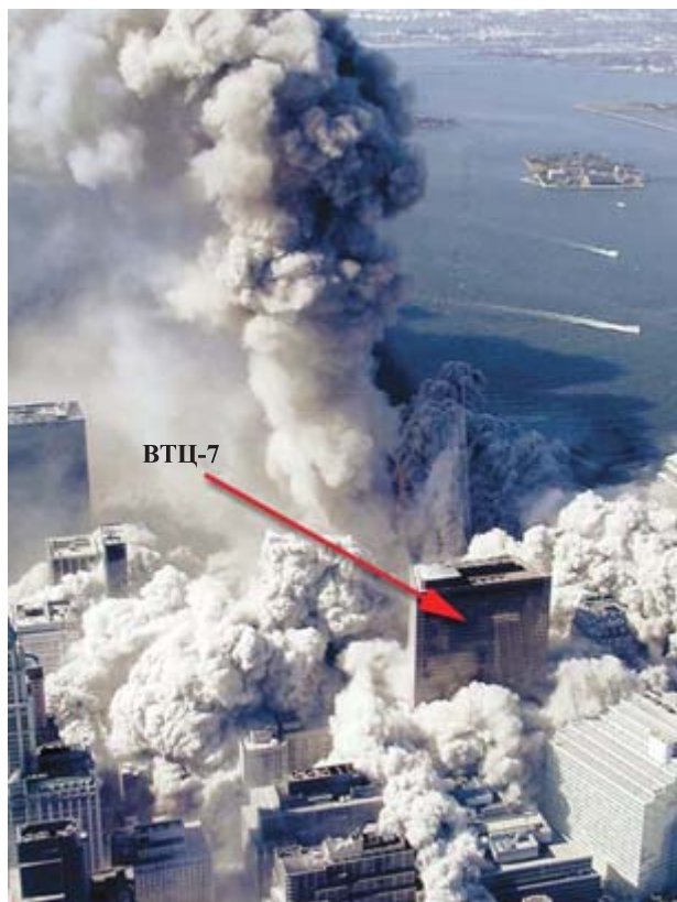
Рис. 4. Здание ВТЦ-7 в зоне прогрессирующего обрушения Северной башни
