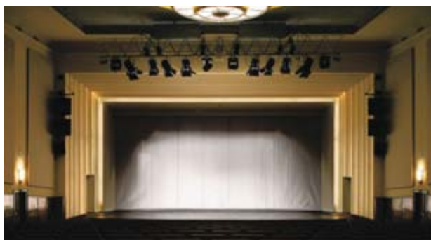
Рис. 30. Применение противопожарных штор в театральных залах
