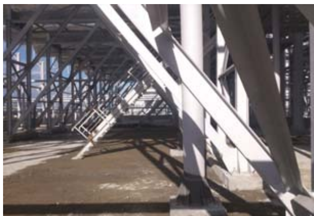
Рис. 5. Система покрытий НЕМРАQUICK PRIMER 13624 + НЕОФЛЭЙМ®514 Р + НЕМРАTHANE HS 55610 (Ленинградская обл., г. Усть-Луга, Морской торговый порт, эксплуатация 2 года в атмосферных условиях)
