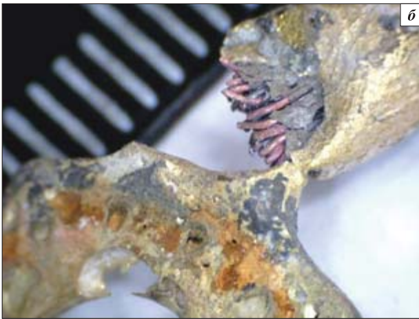
Рис. 2. Повреждения кабельного наконечника провода массы автомобиля Lada 21144: а — общий вид; б — увеличение
