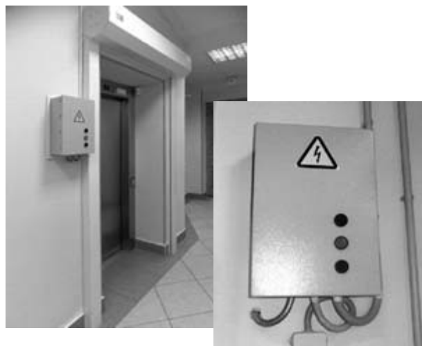
Рис. 16. Общий вид противопожарной шторы с блоком управления
