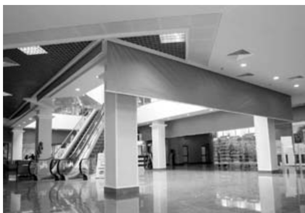
Рис. 22. Применение спринклеров в сочетании с противопожарной шторой
