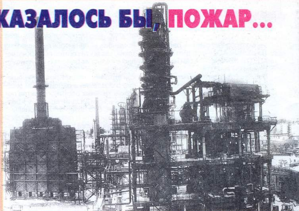
Блок подготовки сырья цеха № 22
