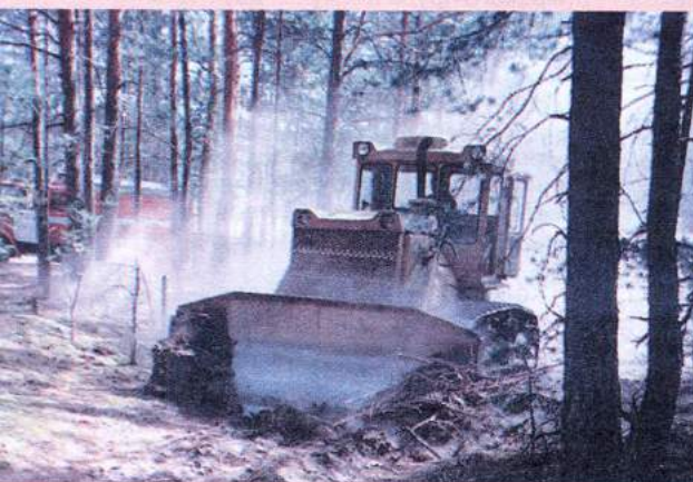
Бульдозер прокладывает дорогу пожарной машине
