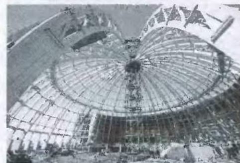
Рис. 5.7. Несущие деревянные клеёные конструкции при строительстве аквапарка в парке 300-летия Санкт-Петербурга
