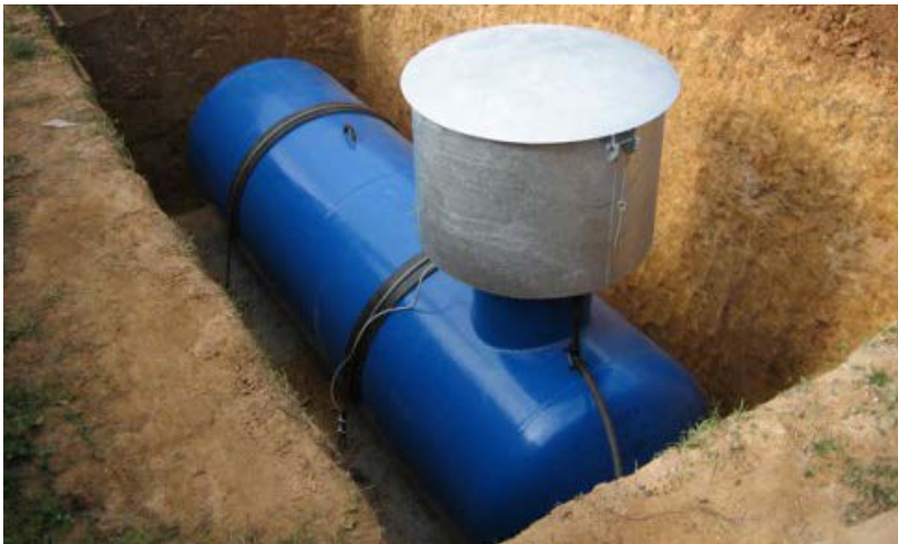
Рис. 1.3. Подземное размещение резервуара (газгольдера) для хранения СУГ
