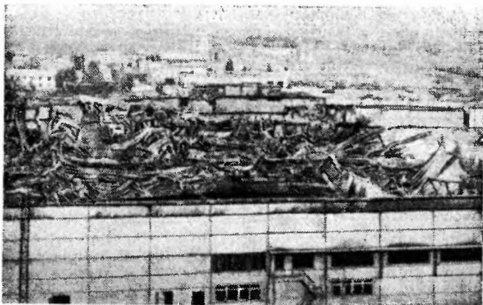
**Рис. 90. Обрушившееся покрытие из профилированного настила**
