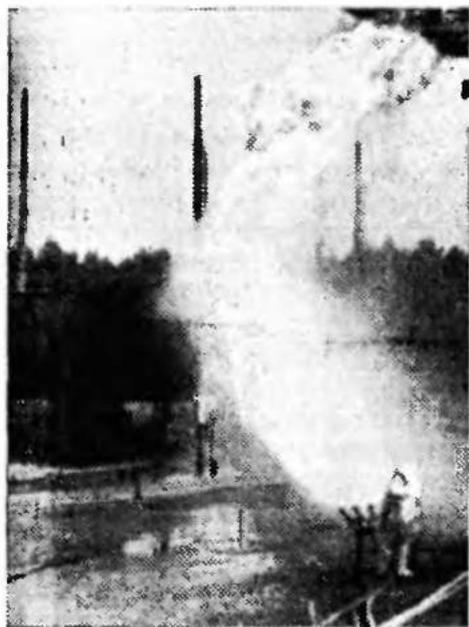
**рис. 113. Орошение факела горящего газа и оборудования распылителями НРТ**
