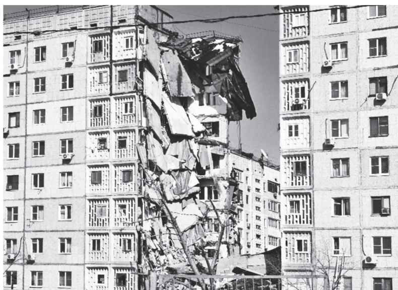
Рис. 13.5 Этапы (а) и последствия (б) разрушения подъезда жилого здания (27.02.2012, г. Астрахань)
