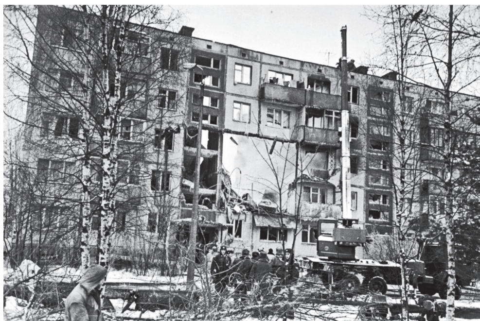
Рис.13.10. Последствия взрыва газа в квартире жилого дома в Приозерске Ленинградской области (1996 г.)
