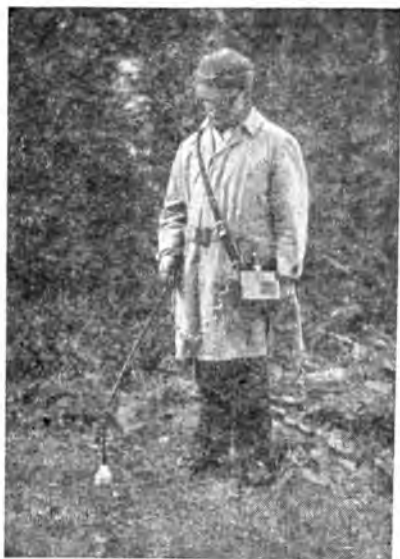
Рис. 15. Инфракрасный прибор для обнаружения «скрытых» очагов горения
