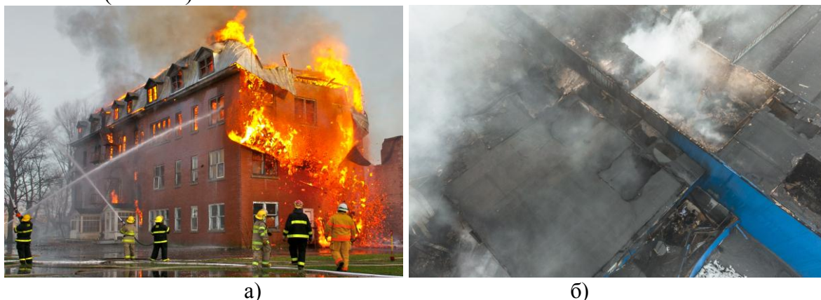
Рис. 2.5. Обрушения конструкций кровли и перекрытий а – административного здания; б – промышленного объекта
