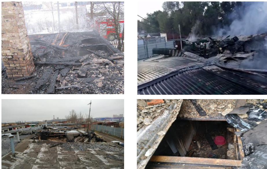
Рис. 2.2. Прогары в перекрытиях при пожарах в жилых домах III-V степеней огнестойкости
