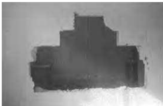
Рис. 3.19. Пролом отверстий в каменных стенах
