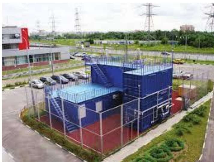
Рис. 4.1. Пример тренировочного комплекса подготовки пожарных и спасателей
